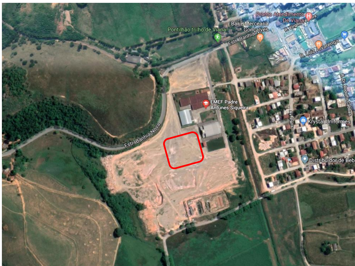
Figura 01 – Localização da Construção do Galpão.
