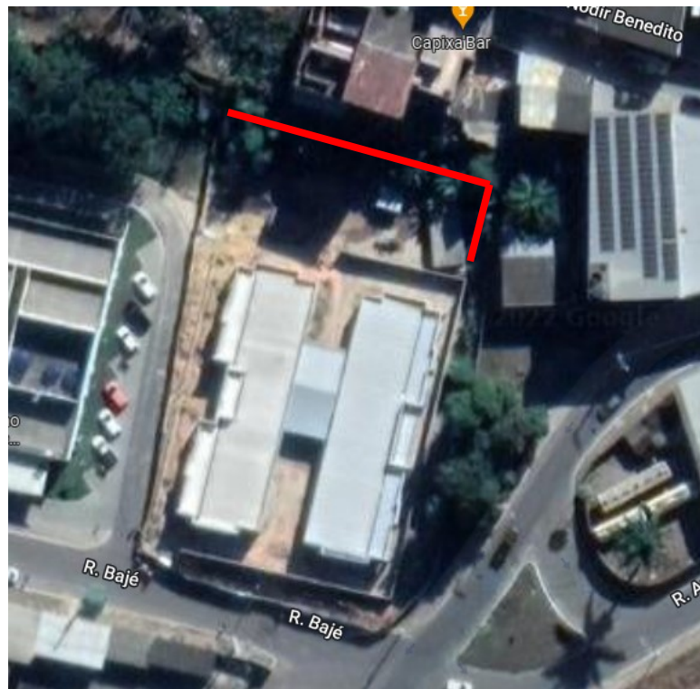
Figura 01 – Localização do Muro de Contenção – Próximo ao CMEI PRIMAVERA.
