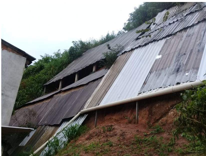
Foto 01 – Talude localizado na Rua Alcides Rodrigues Sales
