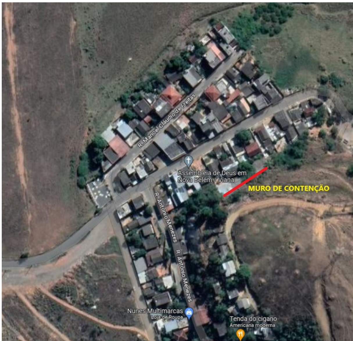
Foto 01 – Localização do talude na Rua Alcides Rodrigues Sales
